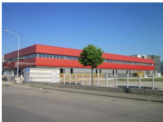
Figura 5: Immagine esterna del Datacenter
